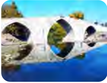
Görsel 5.8: Valide Kösem Sultan Köprüsü, Karamürsel
