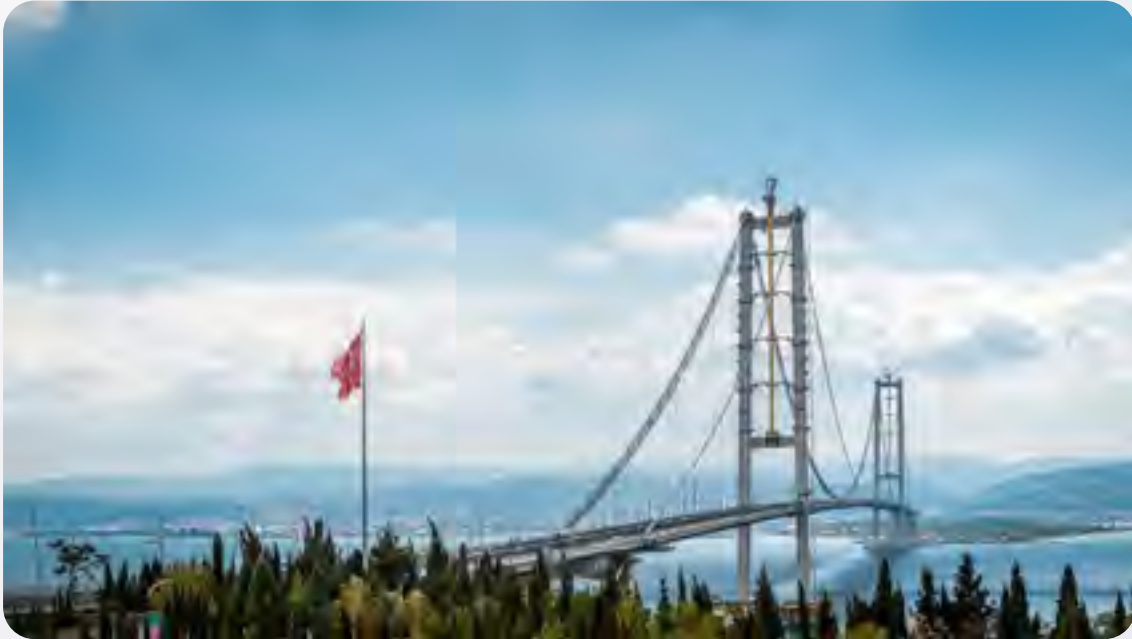
Görsel 4.47: Osmangazi Köprüsü
